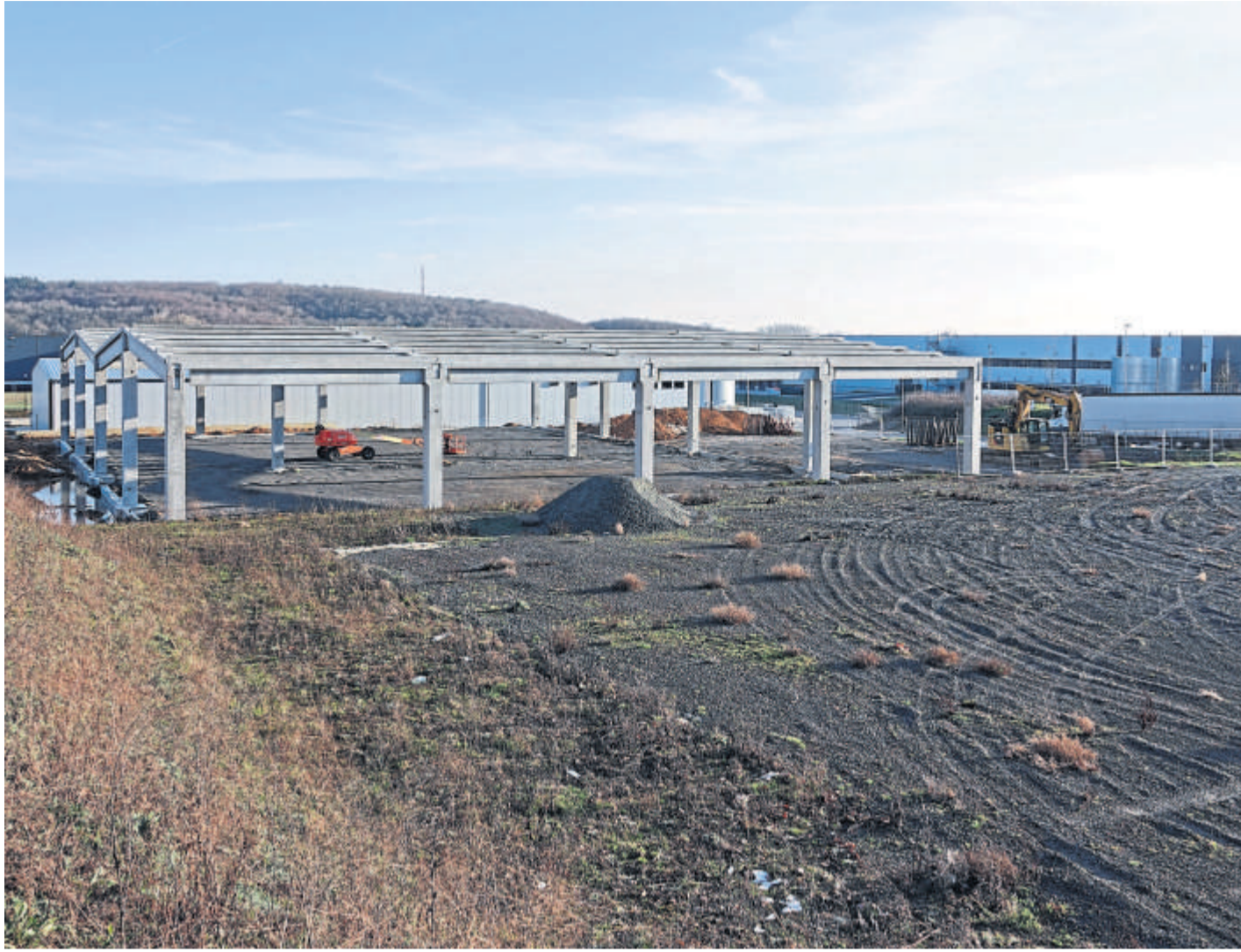
Das gemeinsame Gewerbegebiet der Stadt Büdingen und der Gemeinden Hammersbach und Limeshain polarisiert seit einigen Jahren schon die Region.
